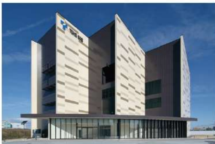
みなとアークス エネルギーセンター外観
