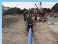
水道管への STREAM工法の適用
