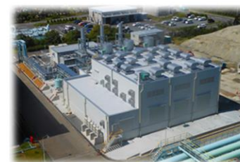
四日市発電所
