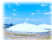
ガス製造・供給
