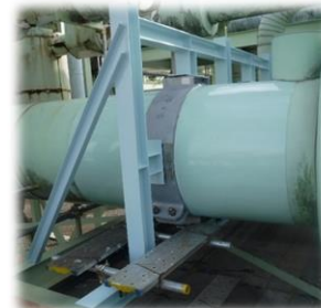
都市ガス工場の災害対策 (LNG受入配管の補強)
