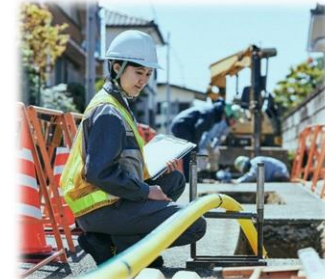
地震に強いポリエチレン管への入替等による導管耐震化率向上
