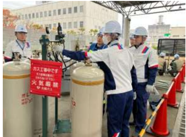
移動式ガス発生設備の組立訓練
