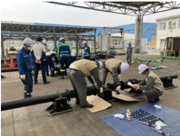
配管の接合訓練
