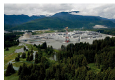
LNG Canada Project
