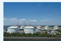
Chita LNG Terminal
