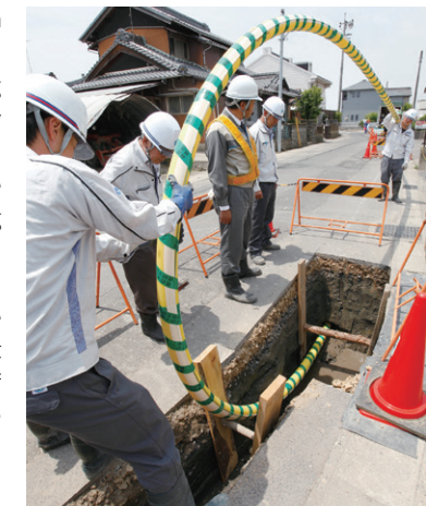
PE pipe installation
