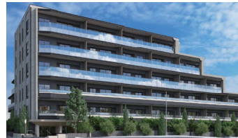
▲社員寮跡地に建設中の分譲マンションの外観デザイン(イメージ)
