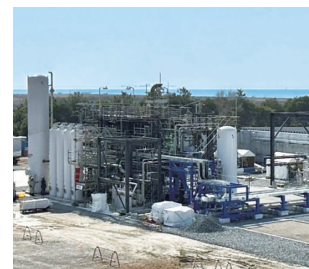
▲建設中の水素製造設備
