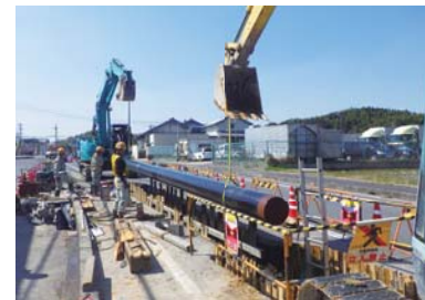
▲三重幹線の建設工事
