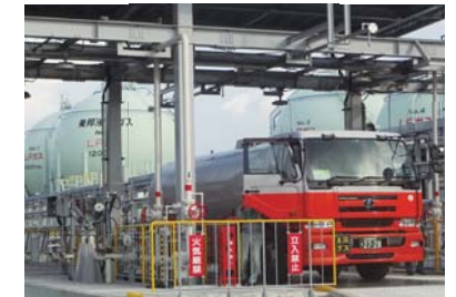
▲名港LPG基地のローリー出荷設備 (東邦液化ガス)
