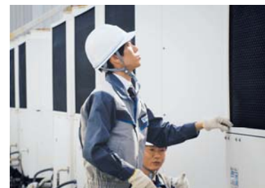
▲省電力で高効率なガス空調システム
