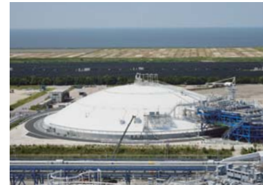
▲完成した知多緑浜工場 No.3LNGタンク
