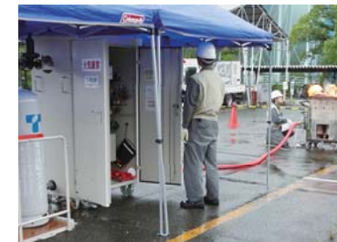
▲被災した重要施設への臨時供給訓練
