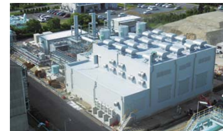
▲ガスコージェネレーションシステムを利用した発電設備
