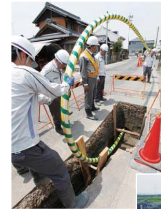
◀耐震性に優れたポリエチレン管への入れ替え
