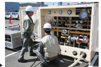
病院などで使用する移動式ガス発生設備設置訓練▶
