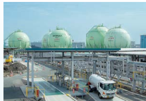
東邦液化ガス(株)名港LPG基地
