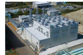
四日市発電所
