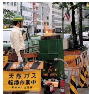
名古屋駅周辺での天然ガス転換作業
