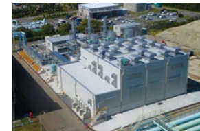
四日市発電所
