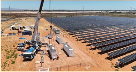
YES Groupが保有する太陽光発電所・蓄電池(建設中)
