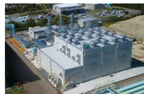
四日市発電所
