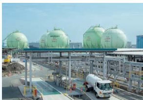
東邦液化ガス(株)名港LPG基地
