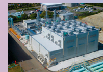
四日市発電所
