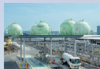
東邦液化ガス(株) 名港LPG基地
