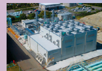
四日市発電所
