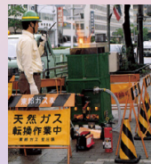
名古屋駅周辺での 天然ガス転換作業
