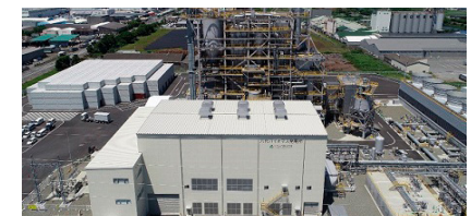
「八代バイオマス発電所」(2024年6月運転開始)
