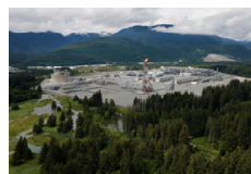
LNGカナダプロジェクト
