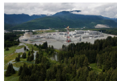
LNGカナダプロジェクト
