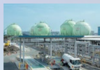
東邦液化ガス(株) 名港LPG基地
