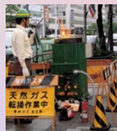
名古屋駅周辺の 天然ガス転換作業
