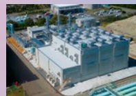
四日市発電所
