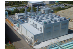
四日市発電所
