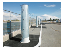
工場の漂流物対策「津波スクリーン」
