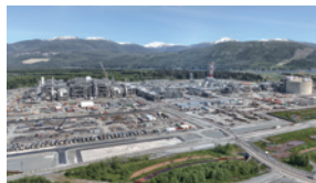
LNGカナダプロジェクト（建設中）
