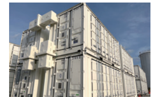
津蓄電所（建設中）
