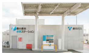
豊田豊栄水素ステーション
