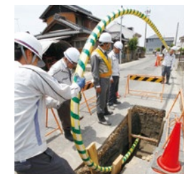
ポリエチレン管の敷設
