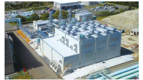
四日市発電所
