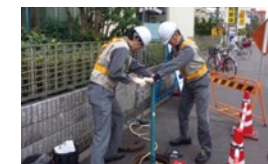
低圧遮断システム導入作業
