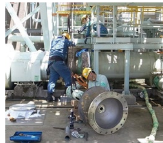
高経年製造設備の更新
