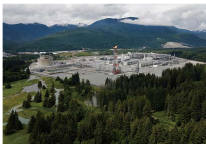
LNGカナダプロジェクト
