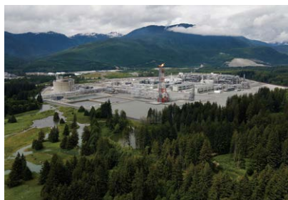
LNGカナダプロジェクト
