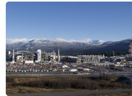
LNGカナダプロジェクト (建設中)
