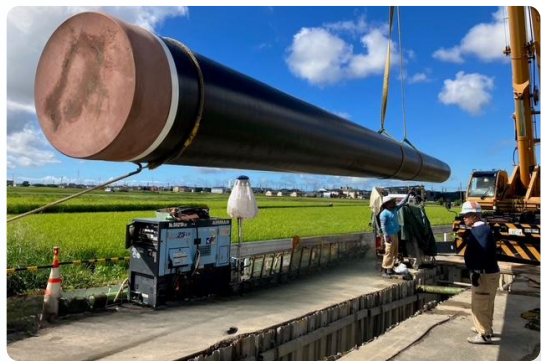
ガス導管の新設工事
