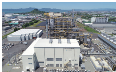
八代バイオマス発電所
