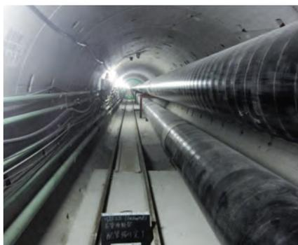
伊勢湾横断ガスパイプラインのシールドトンネル内のガス管(600A)
