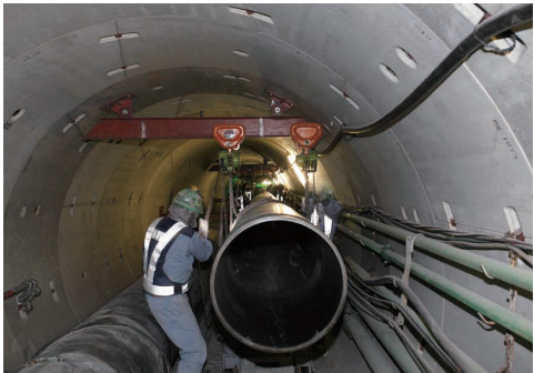
シールドトンネル内の配管作業
