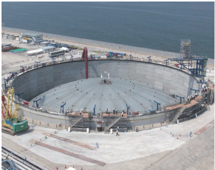
No.2 LNG タンクの屋根浮上
