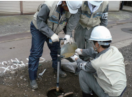
新潟県中越沖地震におけるガス導管の採水作業
