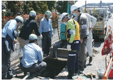
東日本大震災で復旧隊本隊のガス導管の復旧作業
