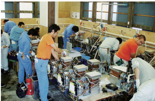
江南地区の天然ガス転換における機器調整作業
