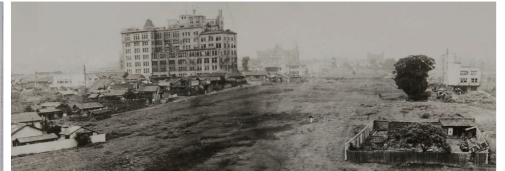
復興計画に基づく100メートル道路の建設 （中日新聞社提供）
