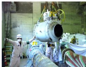
ガス製造工場の高経年化対策 (主要送ガス管のバルブ交換)
