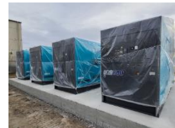
2021年度の稼働に向けて建設中のバイオマス発電所
