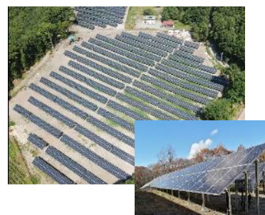
稼働済の太陽光発電所
