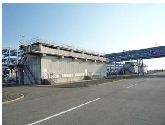
LNG を海水との熱交換によりガス化する設備です。
