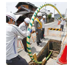
PE pipe installation
