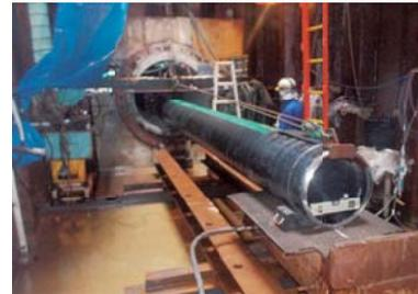
▲推進工法による鉄道横断工事
