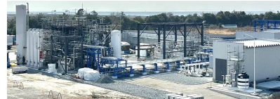
水素製造設備(建設中)
