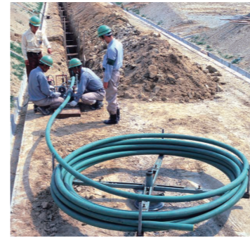
ポリエチレン管の施工
