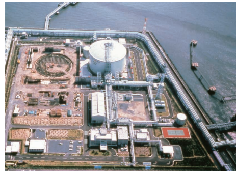
完成した四日市工場
