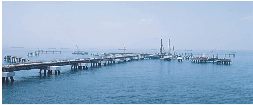
知多LNG第2栈橋(L2栈橋)建設工事
