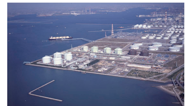
知多LNG共同基地と知多エル・エヌ・ジー知多LNG事業所
