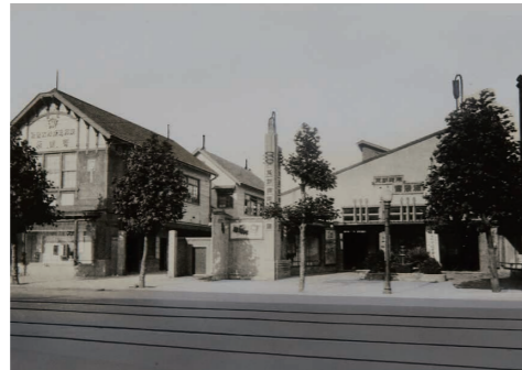
本部営業所(左)の横に設置されたガス応用実験場(右)
