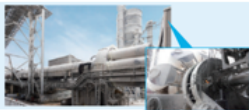
石灰焼成キルン全体像 燃焼部分
