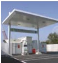
◆IMTSバスの専用スタンドでCNG(圧縮天然ガス)を充てん。磁気マーカーによりディスペンサー直前まで自動制御されています。
